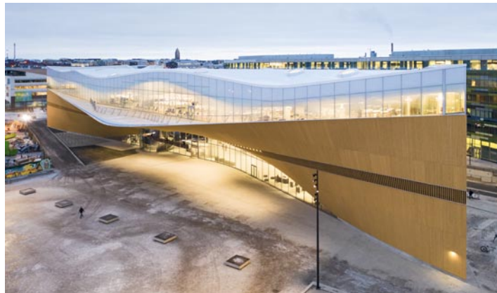
Fig. 24 Helsinki, Oodi (ALA Architects, 2018). © Tuomas Uusheimo
