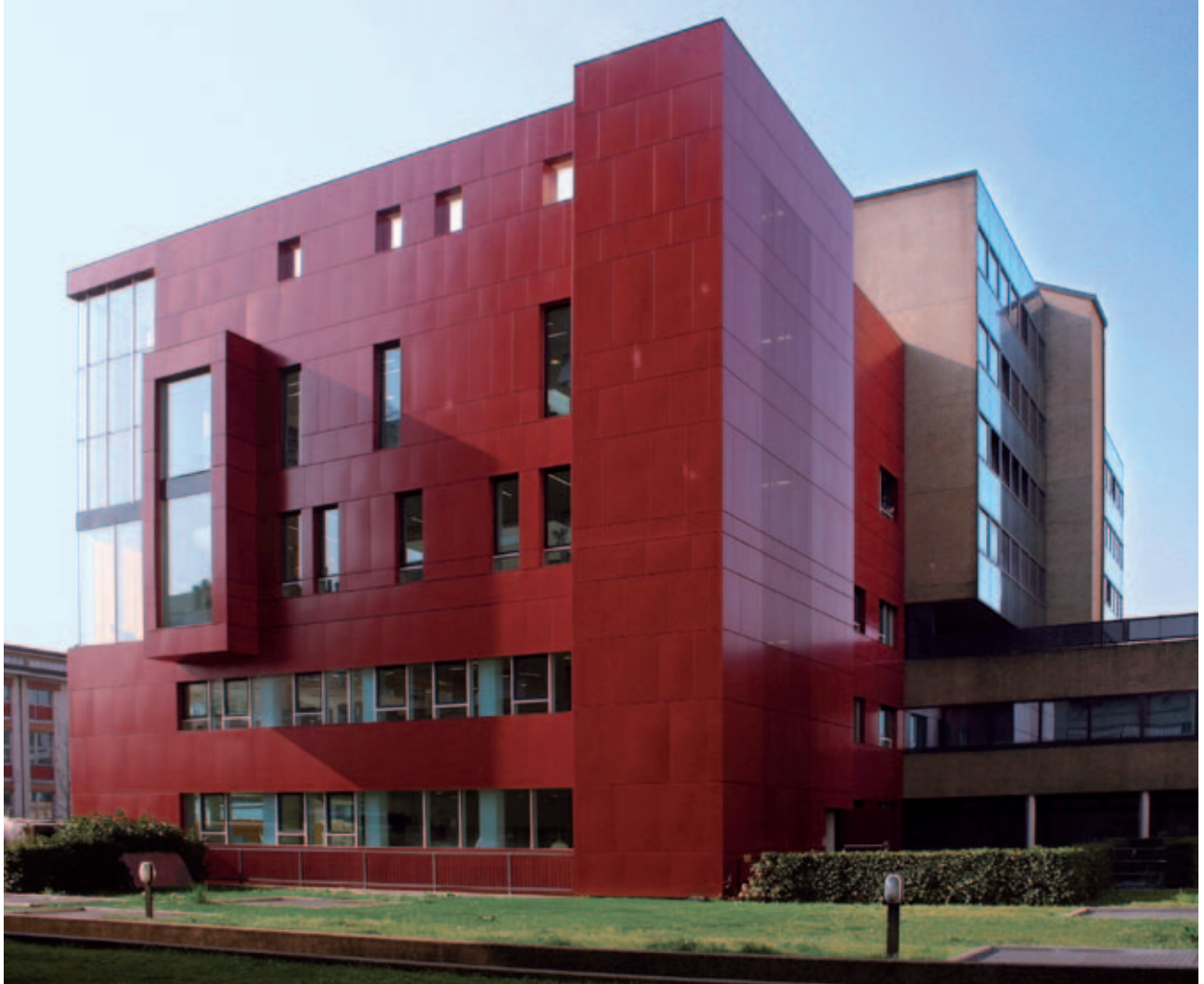
Veduta esterna dal giardino adiacente alla MedaTeca (Foto © Matteo Schubert)
